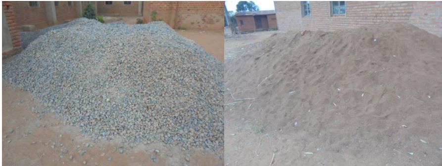
Materialen (stenen en zand) voor de kerkvloer
